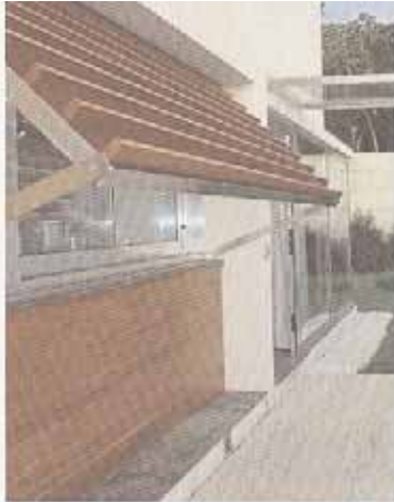
Particolare frangisole cucina
